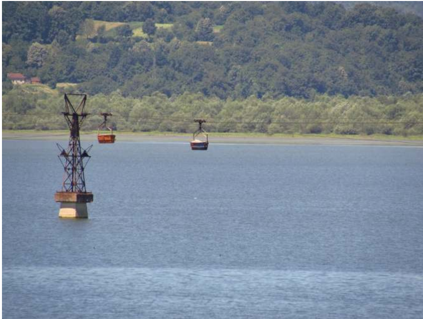
SLIKA 8 – ŽIČARA IZ PK VIJENAC KOJA PRENOSI KREČNJAK
