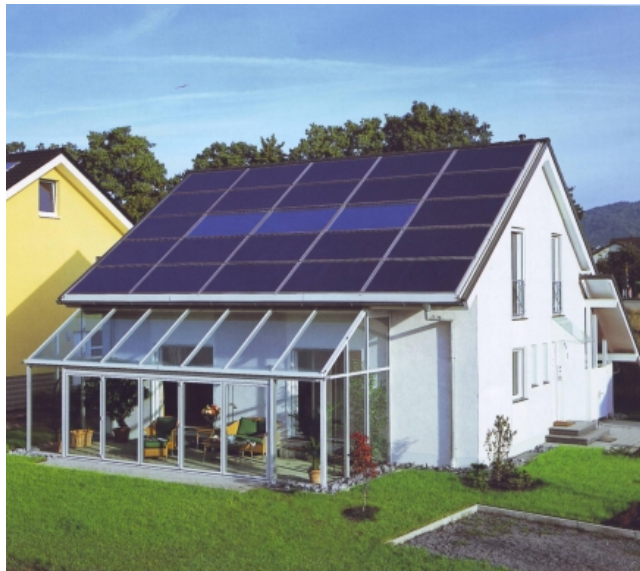
SLIKA 10 - KORIŠTENJE SOLARNIH PANELE NA OBJEKTIMA
